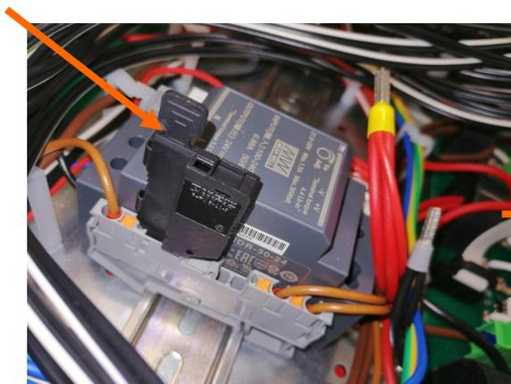
Abb.: Innenraum NR 8016, Sicherungsreihenklemme auf Hutschiene (neben Hauptschütz)
