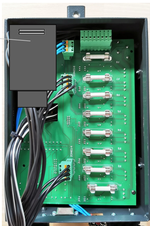
Abb.: NR8008 SGM, Gerätedeckel geöffnet, Leistungsplatine mit Schmelzsicherungs-Einsätzen zugänglich
